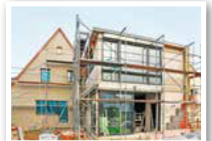
Umbau, Anbau – bei Familie Dorweiler wurde ein Jahr lang kräftig modernisiert. Der alte Gebäudeteil wurde gedämmt und mit Wärmeschutzfenstern aufgerüstet
